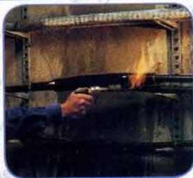
Empalme termocontráctil 100% hermético de 5 a 69 kV. Recto o en derivación. Raychem
